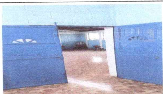
Foto 3: sustitución de puerta de madera por puerta de metal
