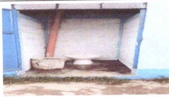
Foto 2: pintura de paredes interiores de los baños
