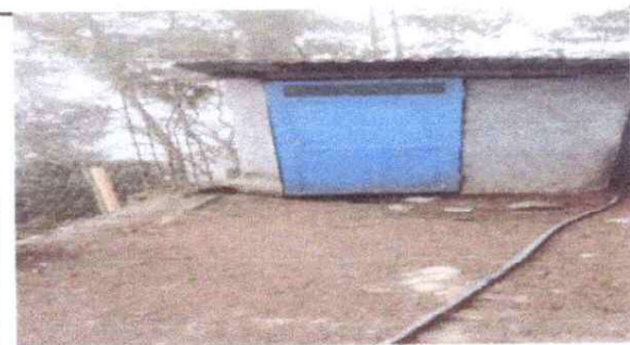
Foto 5: Sustitución de puertas de madera por puerta de metal
